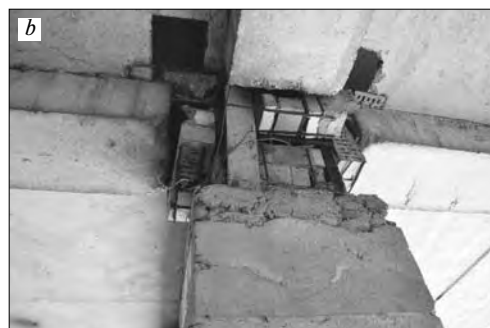
Рис. 5. Стенки двутавровых колонн заложены кирпичной кладкой, металл полок подвергается сплошной язвенной коррозии Fig. 5. The walls of the I-beams are laid with brickwork, the metal of the shelves is subject to continuous pitting corrosion
