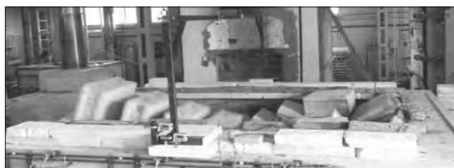
Рис. 5. Вид плит с АСК после обрушения
