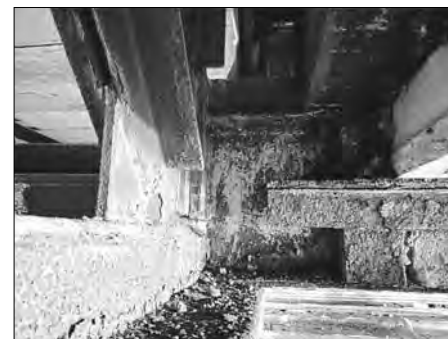
Рис. 13. Характерное состояние металла фермы покрытия центральной части стилобата
