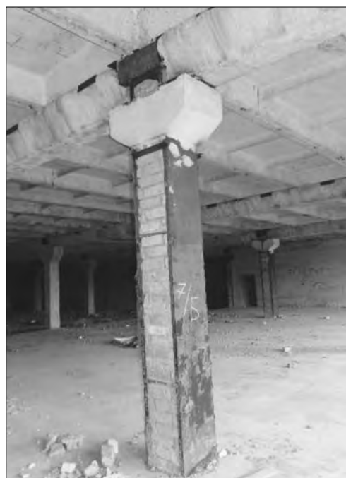
Рис. 5. Стенки двутавровых колонн заложены кирпичной кладкой, металл полок подвергается сплошной язвенной коррозии Fig. 5. The walls of the I-beams are laid with brickwork, the metal of the shelves is subject to continuous pitting corrosion
