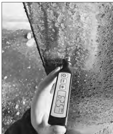
Рис. 13. Характерное состояние металла фермы покрытия центральной части стилобата
