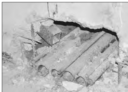
Рис. 15. В диафрагме перерезан жесткий профиль
