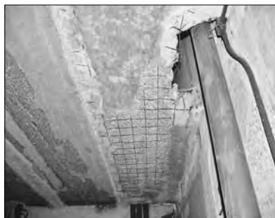
Рис. 9. Повреждения целостности многопустотных плит в зонах проходок коммуникаций Fig. 9. Damage to the integrity of hollow-core slabs in the communication penetration zones
