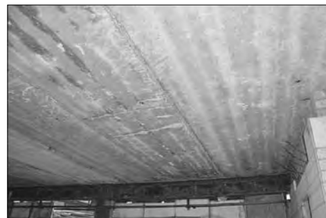
Рис. 10. Поперечные сквозные трещины и недопустимый прогиб плиты перекрытия Fig. 10. Transverse through cracks and unacceptable deflection of the floor slab
