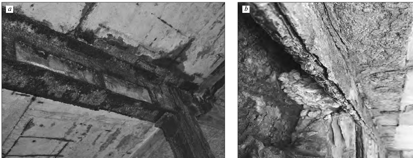
Рис. 12. Характерное состояние металла балок балконов третьего (а) и четвертого этажей (b) Fig. 12. Typical state of the metal of the beams of the balconies of the 3rd (a) and 4th (b) floors
