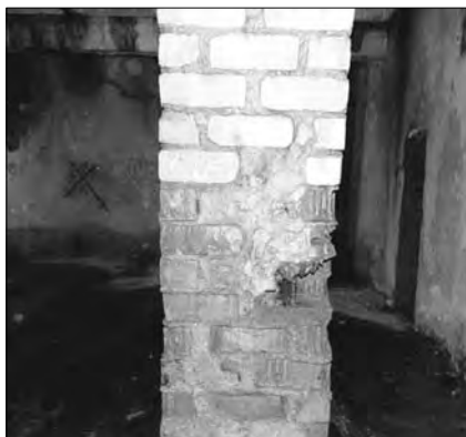
Рис. 2. Облицовка колонны подвала в осях 4/Б пустотелым кирпичом Fig. 2. Facing the basement column in axes 4/B with hollow brick
