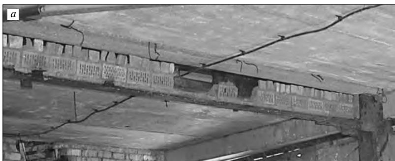
Рис. 6. Характерная закладка кирпичами стенки балки (а) и узла сопряжения балок с колонной (b) Fig. 6. Typical brick laying of the beam wall (a) and the junction of the beams with the column (b)
